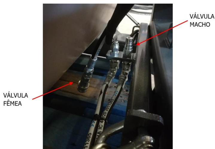
Figura 7.5 – Válvulas engate rápido – alimentação do sistema de basculamento do Tinão
